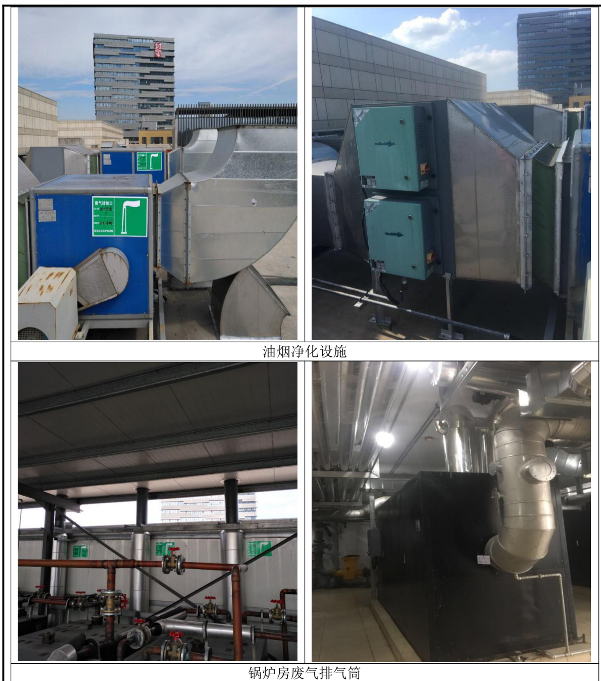
图 4-5 废水、废气处理设施
